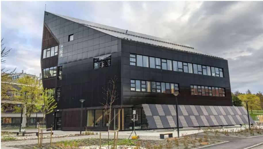
ZEB-laboratoriet i Trondheim er kledd i bygningsintegreerte solceller – her er det solceller på alle fasader og på tak. Foto: Solcellespesialisten
