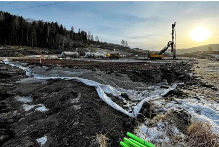
bruk på riksvei 4-utbyggingen på Hadeland for å vispe inn kalksementpeiler. Foto: Hæhre
